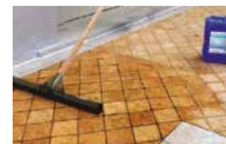
Verser **PROTECH BALCONY** sur les zones à imperméabiliser, en le répartissant avec une raclette à eau et insister sur les joints entre les carreaux et la plinthe. Laisser réagir le produit au moins une heure avant d'effectuer le test d'inondation superficielle. Ces opérations devront être effectuées une fois que les joints auront séché.
