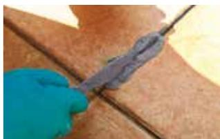
Les fissures et les irrégularités mises en évidence avec le nettoyage devront être soigneusement mastiquées avec l'enduit hydrofuge **STUCCO BALCONY**, même au niveau de la plinthe et des seuils. Les éventuels joints de dilatation devront être traités avec **PROTECH FLEX**, le mastic polyuréthane en cartouche extrudable extrêmement élastique.
